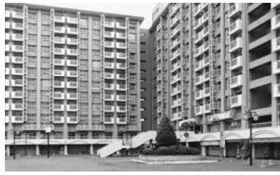
解体される予定の多摩川住宅ロ-16号棟
